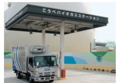
バイオガスステーション
