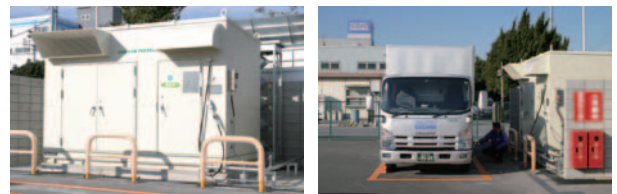
自家用天然ガス充填スタンド(城西店) 天然ガストラックに充填するようす
